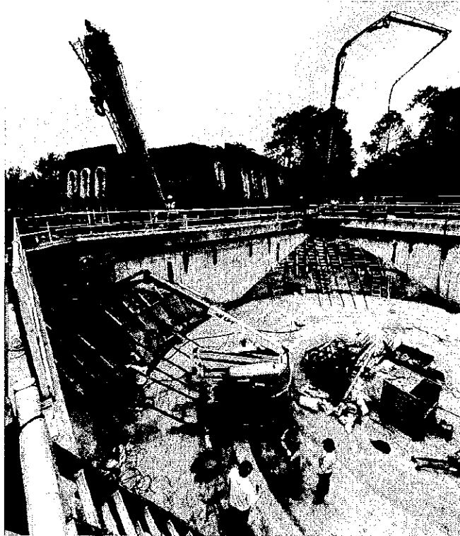
(11/19) – Concrete pour of top corner sections.
